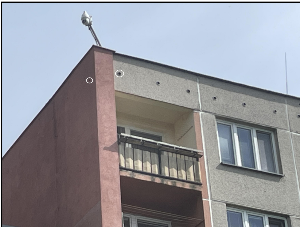
Obr. 1: Příklad podstřešního ventilačního otvoru bez mřížky (elipsa vpravo) a díra v zateplení (elipsa vlevo) u JZ rohu č. p. 394 – potenciální stanoviště předmětných živočichů
